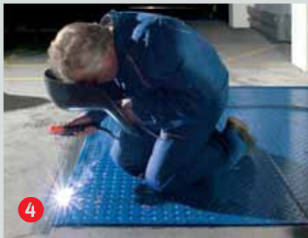
Navarí se na obvodový úhelník - hotovo!
