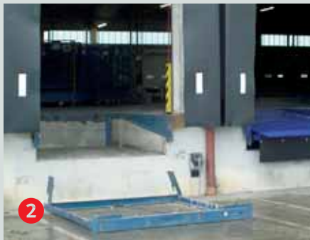
Demontuje se starý základní rám
